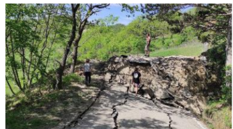
Frana e strada interrotta a Montemirabello di Predappio
